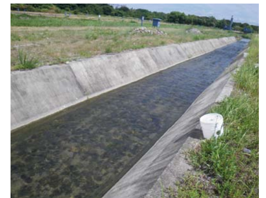
写真1 土砂投入状況(上)と実験区の状況(下)
