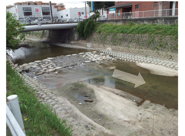
写真2 施工後の早瀬工の状況
