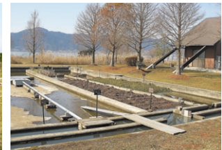
植生浄化実験施設と見学者棟
