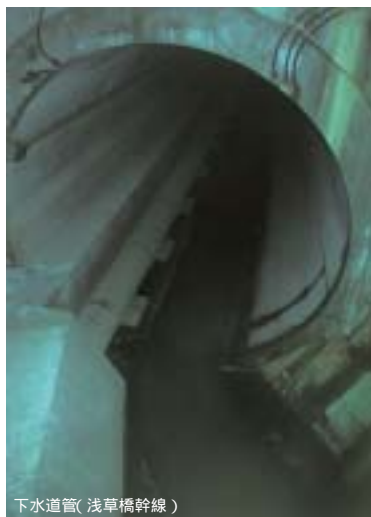
下水道管(浅草橋幹線)
