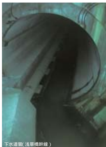
下水道管(浅草橋幹線)
