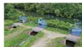
配水池・配水ゲート
