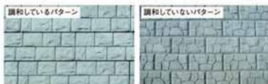
図4 ブロックの輪郭と表面模様の組合せ例
