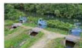
配水池・配水ゲート
