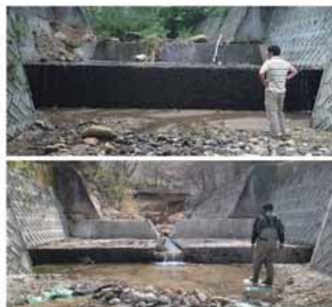
図3 施行前（上）、完成した切欠き魚道（下）
