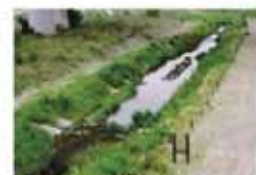
復元工法実施後の写真
