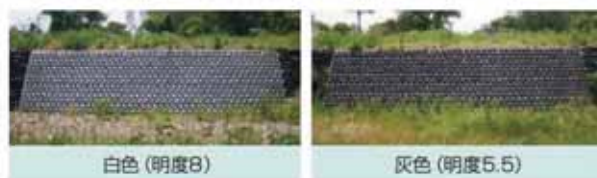
写真2 アンケートに用いた護岸（遠景）
