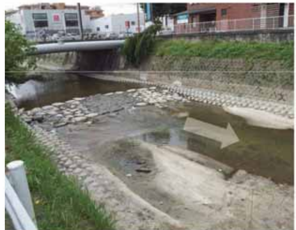
写真2 施工後の早瀬工の状況
