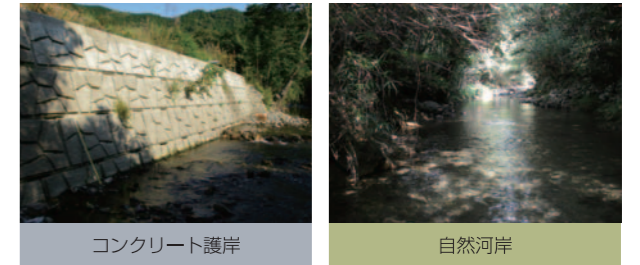
写真1 調査区の様子(コンクリート護岸と自然河岸)
