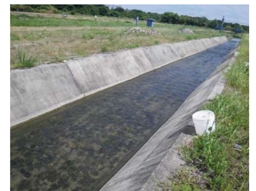
写真1 土砂投入状況(上)と実験区間の状況(下)
