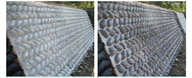
写真1 アンケートに用いた護岸（近景）
