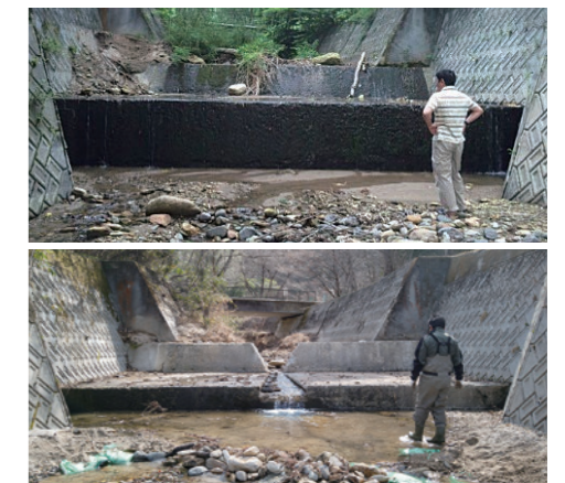
図3 施行前(上)、完成した切欠き魚道(下)
