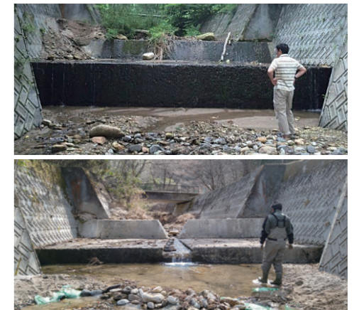
図3 施行前(上)、完成した切欠き魚道(下)
