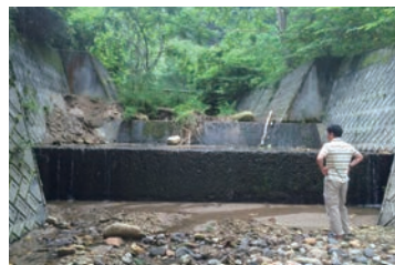
設置前(2.4mの落差)
