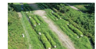
中流ゾーン(遊水地) 越流堤の高さなどを変えられる遊水地では、実験河川の転倒ゲートを用いた人工洪水と併せることで、環境機能の高い遊水地のあり方を検討することができます。(河床勾配: 1/800)
