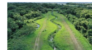
下流ゾーン 最下流にあるこのゾーンでは、川を蛇行させて流れに変化を与え、生き物が川の空間をどのように使うのか、またそれらの環境を保全するための研究をしています。(河床勾配: 1/300)
