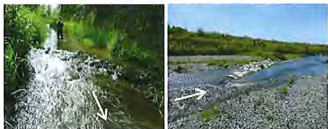
図-1 バープ工の施工事例 (左：精進川放水路、右：日高門別川)
