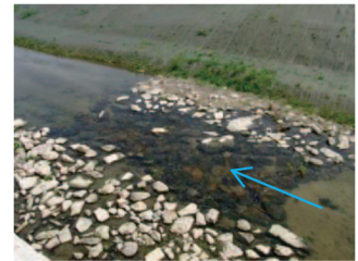
写真-2 早瀬工施工事例 12)
