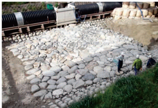
写真-4 早瀬工 (H25 施工)
