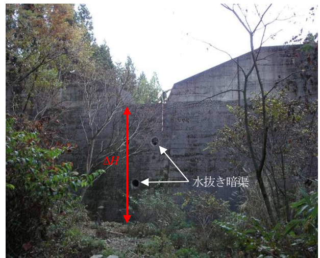
写真-1 砂防えん堤の堆砂状況例
