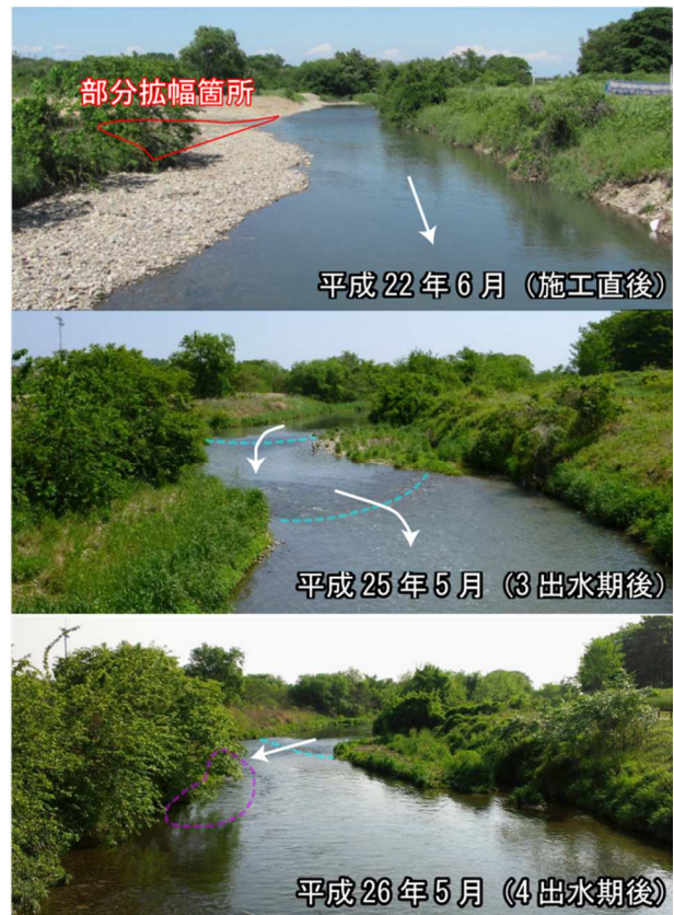
図-1 新境川施工箇所の景観の経年変化（下流側より）
