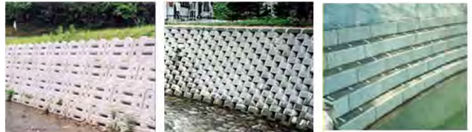
写真-1 検討対象とした景観パターン (左: 穴あき 中: 千鳥-穴あき 右: 階段)
