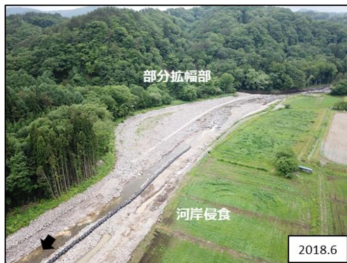
図-2 雫石川の部分拡幅部
