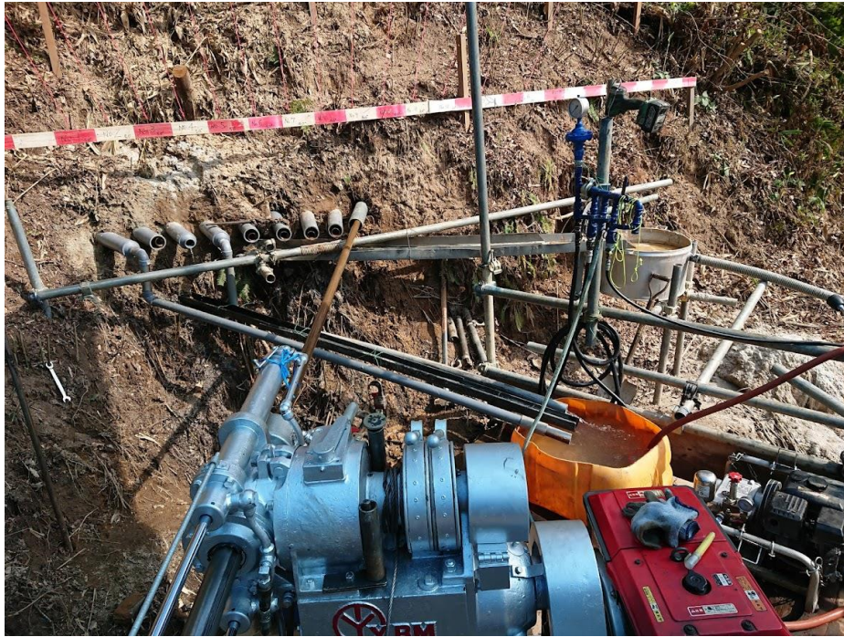
応急横ボーリング工の施工
