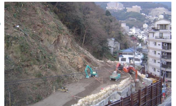
応急対策工事
