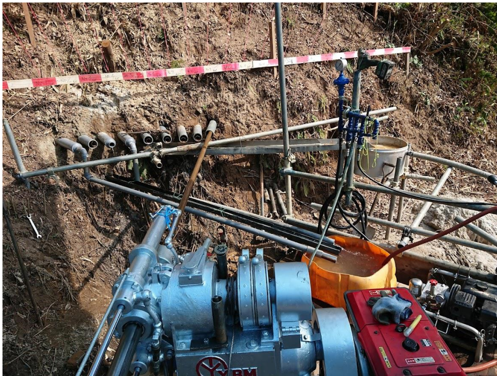
応急横ボーリング工の施工
