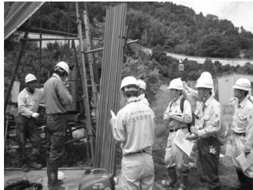
写真 1.2 現地比較試験状況
