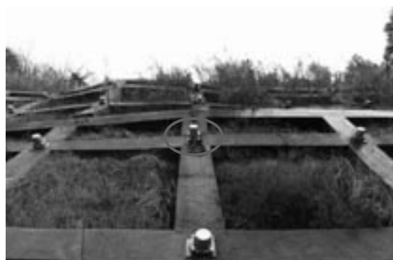
写真 2.7.2 アンカー荷重計の設置状況 (A-2 下段)
