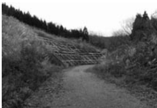
写真 2.7.1 アンカー工の全景
