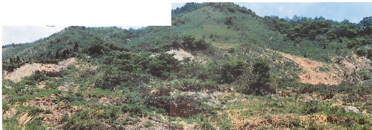
▲最上部滑落崖（昭和45年撮影） Primary scarp (1970)
