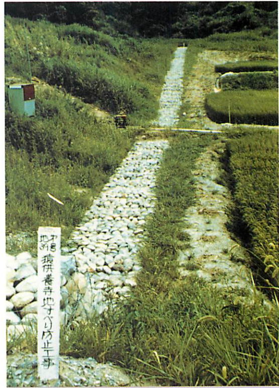
▲ 3号排水壁工完成 (昭和54年撮影) No.3 Pervious wall (1979)
