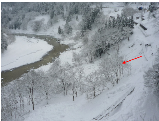
写真-29 地すべり①の全景
