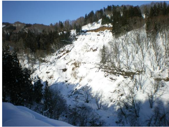
写真-36 移動土塊の崩落状況
