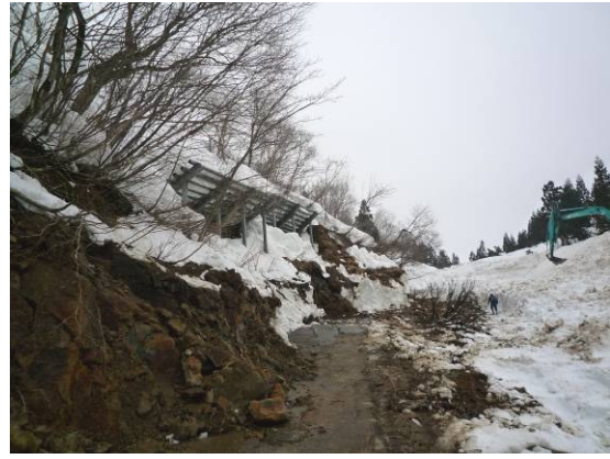
写真-26 末端部の状況
