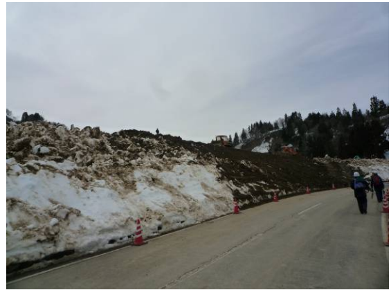
写真-12 末端部の状況 (道路の土砂を除去後)
