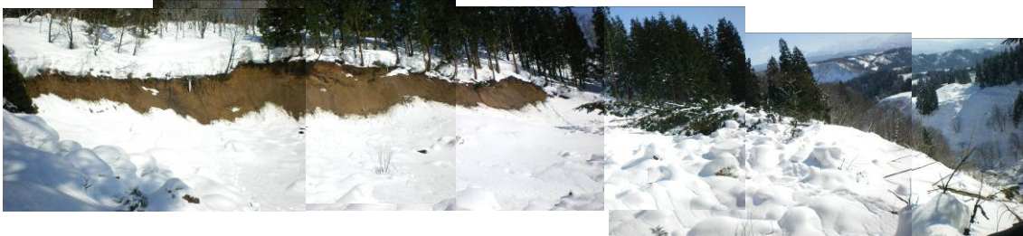
写真-34 地すべり地全景
