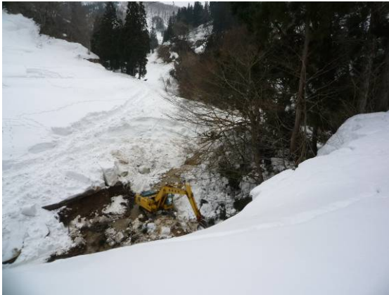
写真-23 末端部の状況
