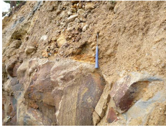
写真-24 地質の状況
