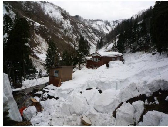
写真-16 地すべりの中腹部
