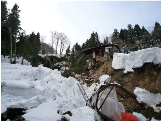
写真-15 地すべりの頭部、左側部
