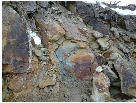
写真-28 地質の状況
