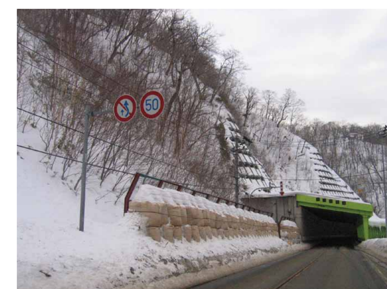
▲ スノーシェッド (北海道浦河町) Snow shed (Urakawa Town, Hokkaido)
