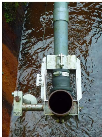
▲写真-4 集水管閉塞防止器孔口の状況
