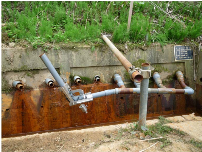
▲写真-2 閉塞物を除去し、集水管閉塞防止器設置 (平成24年5月2日)
