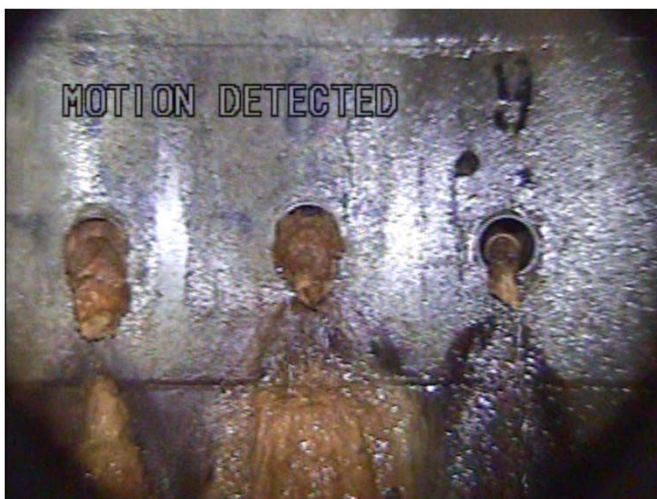
▲写真-3 集水管の状況
