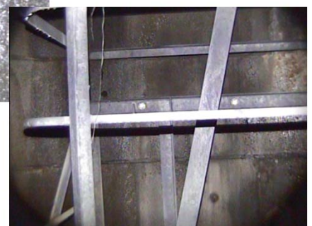
▲写真-5 タラップの状況
