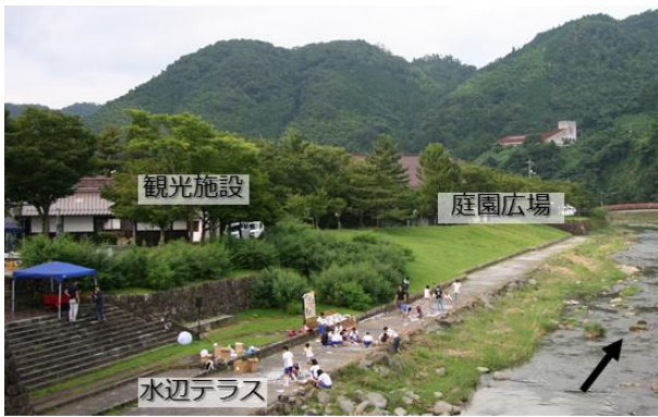
写真-1 津和野川整備箇所
