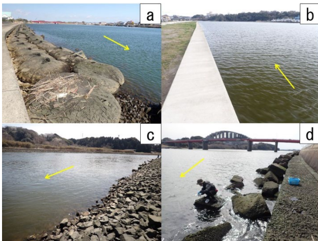
図-2 採水地点の状況。(a)1.0k 右岸：袋型根固め工，(b) 1.0k 左岸：矢板，(c) 瀬沼川 1.0k 左岸：捨石工，(d)0.0k 右岸：消波ブロック，2022/4/2 撮影。
