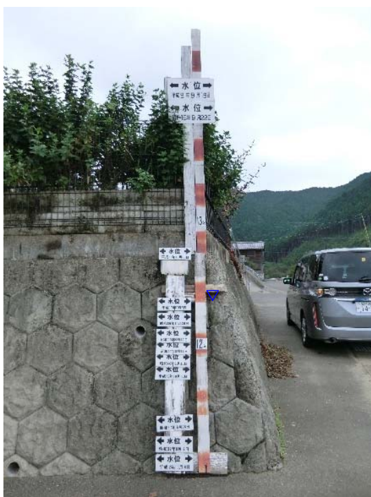
写真1 既往出水における痕跡水位
