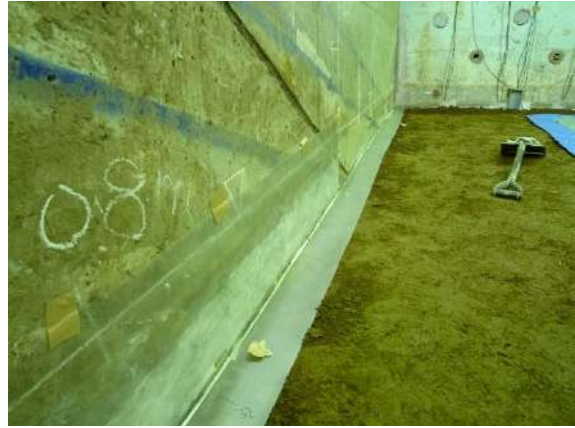
(b) シート壁面貼り付け状況
