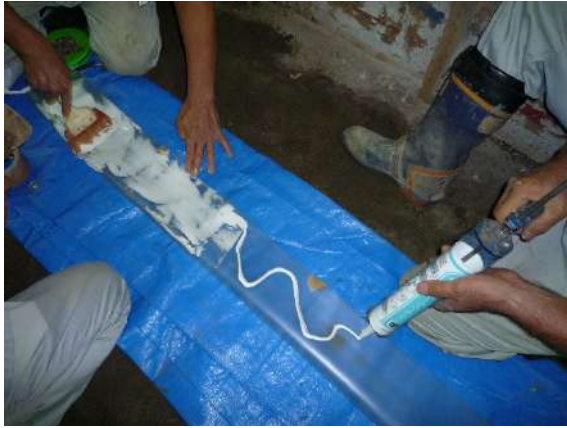
(a) シート片側接着状況
