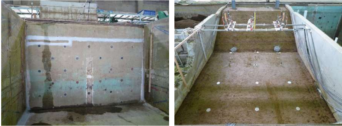
図 2-3 土槽の補修状況（左）と模型・実験の状況（右）
