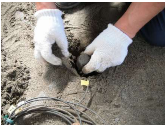
(a) 間隙水圧計設置作業
