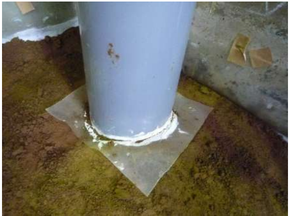
(d) 塩ビ管へのシート貼り付け状況
