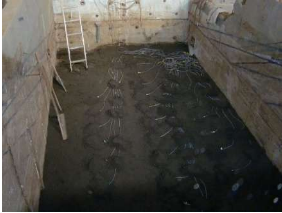
(a) 設置状況
