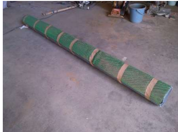
(b) 吸出し防止材を巻き付けた給水塩ビ管
