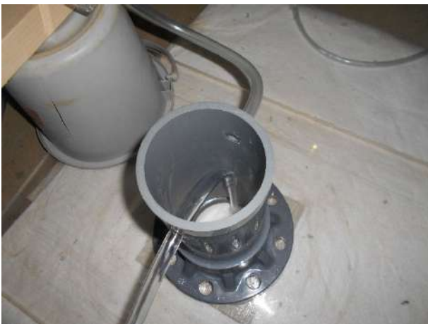
(e) アクリル板と塩ビ管, パイプ設置
