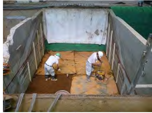
(b) 被覆土層の転圧
