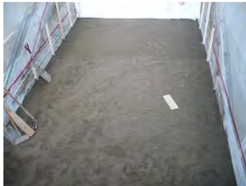
(f) 基礎地盤内への間隙水圧計設置完了
