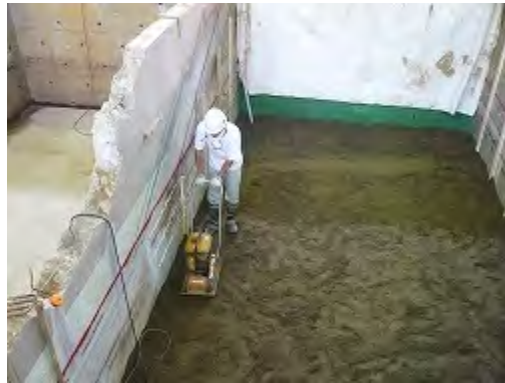
(d) 基礎地盤の転圧
