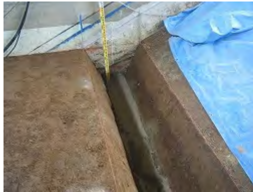
(b) トレンチ掘削完了
