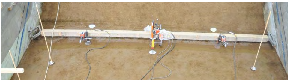
図-1.2.6 変位計の設置状況
