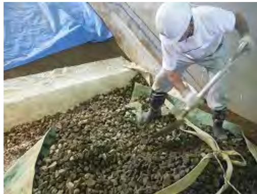
(d) トレンチの埋め戻し材投入
