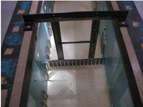
(a) 排水機能付き矢板の仮留め
