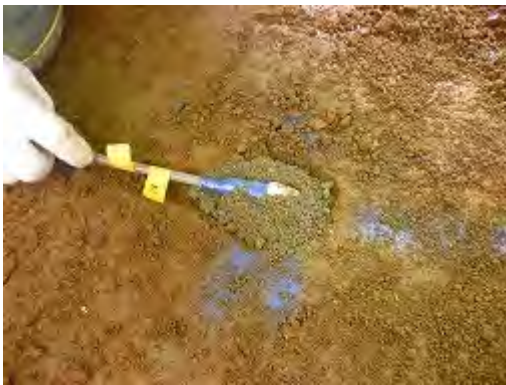
(a) マノメーターの設置状況
