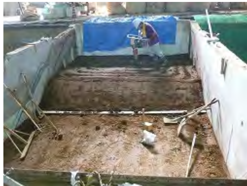
(d) 堤体の転圧
