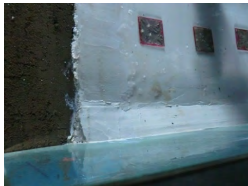
(d) 修復状況
