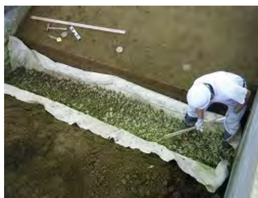
(d) 透水トレンチ材敷設
