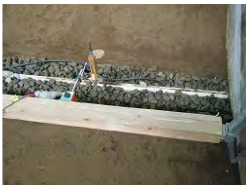
(g) 矢板設置完了
