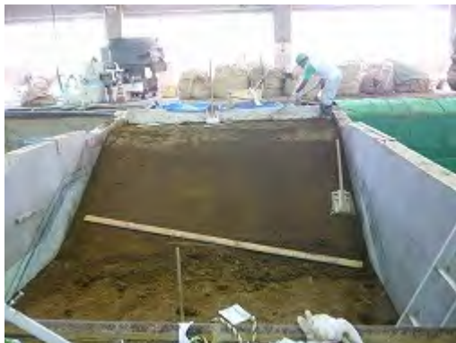
(e) 堤体ののり面整形
