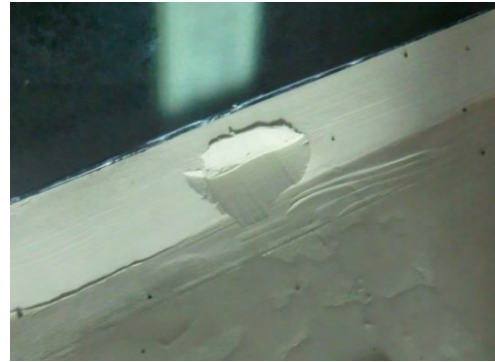
(f) 噴砂直下の掘削写真 (噴砂口は見当たらない)
