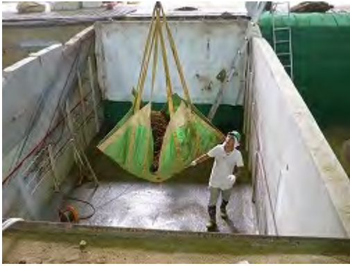
(a) 基礎地盤の盛立て
