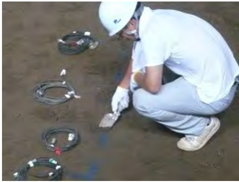
(a) 間隙水圧計の設置状況
