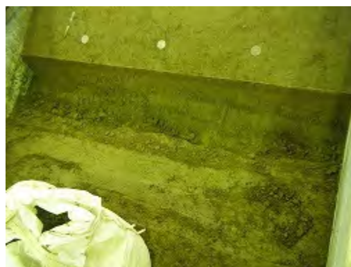
(b) トレンチ部掘削②
