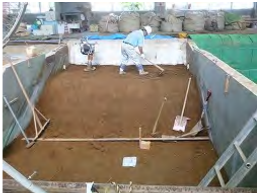
(c) 堤体の敷き均し
