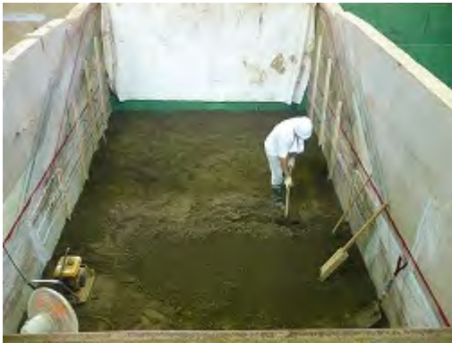
(c) 基礎地盤の敷き均し
