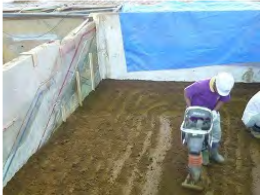
(a) 堤体の転圧
