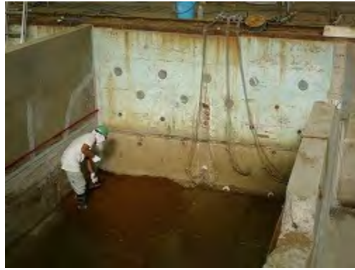
(b) 基礎地盤の敷き均し
