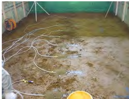
(b) マノメーターの設置状況
