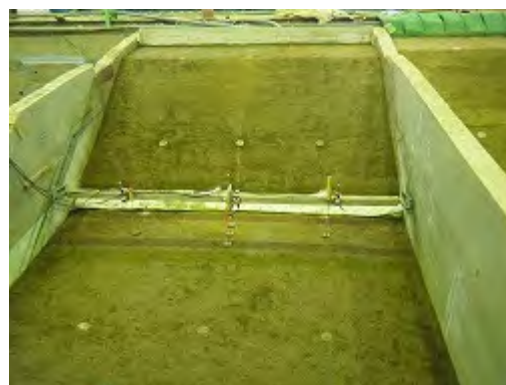
(f) 透水トレンチ設置完了
