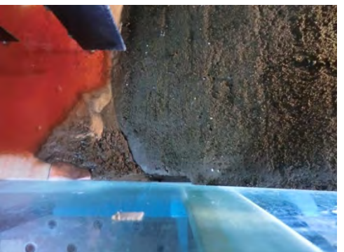
(e) 噴出箇所の平面形状 (のり尻付近)
