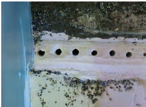
(e) 実験後の平面形状 (対策工箇所)
