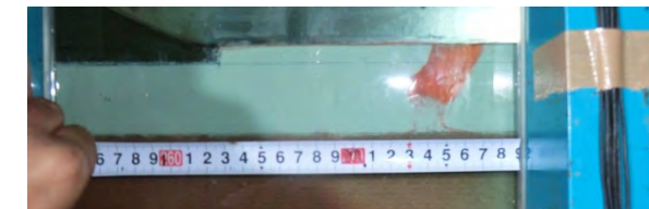
(f) 変状箇所の横断面形状（掘削）
