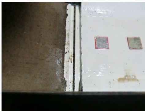
(c) 砕石撤去後の対策工の平面形状
