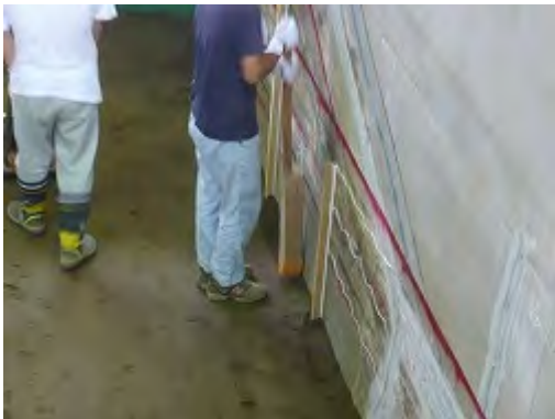
(e) 基礎地盤の側壁付近の転圧
