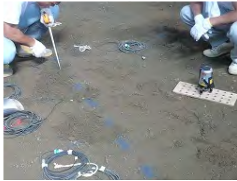
(b) 間隙水圧計の設置状況
