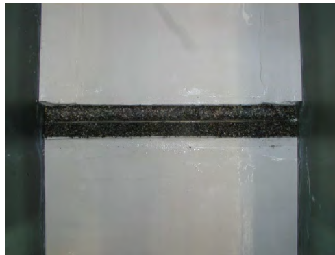
(c) 排水部材上部の埋戻し
