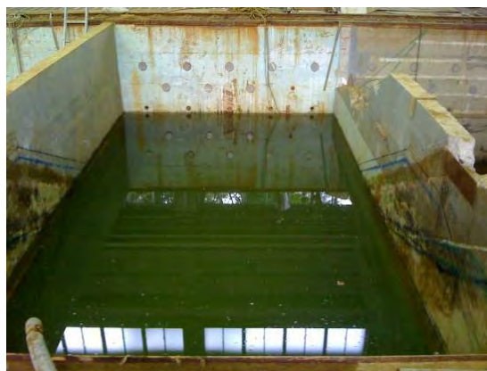
図-1.2.2 実験前の漏水調査の状況
