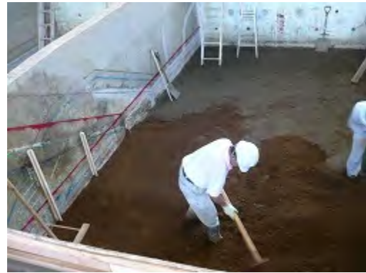
(d) 被覆土層の敷き均し
