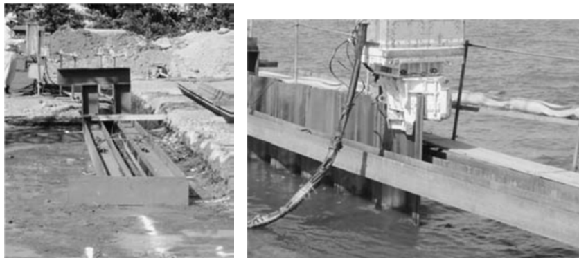
図-9.4.1 導枠工の例
