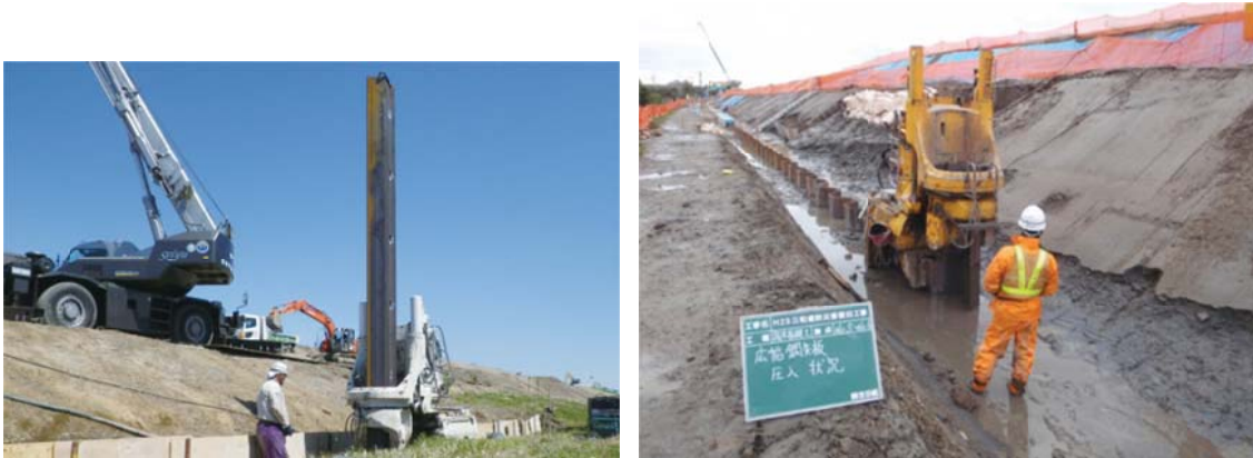
写真-9.4.1 矢板打設状況
