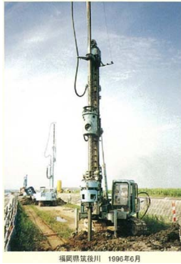
写真-9.3.1 施工状況
