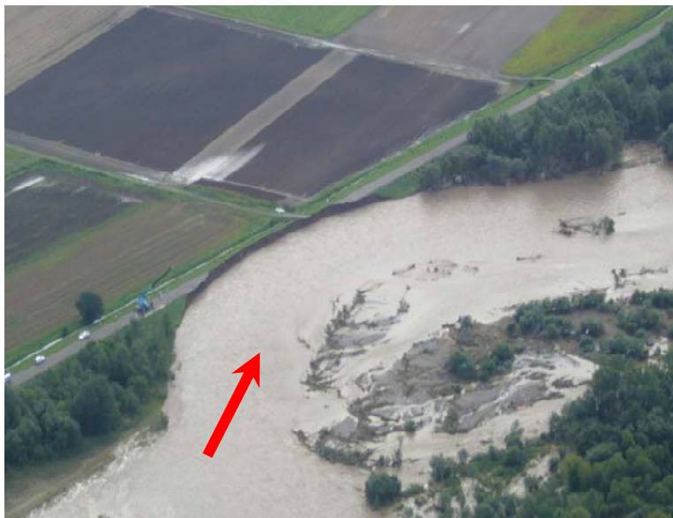
図 2.2.1 侵食による被災 (H23.9・音更川)
