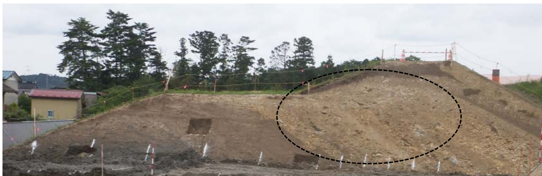
天端からの撒き出しによって形成されたと考えられる斜めの構造
