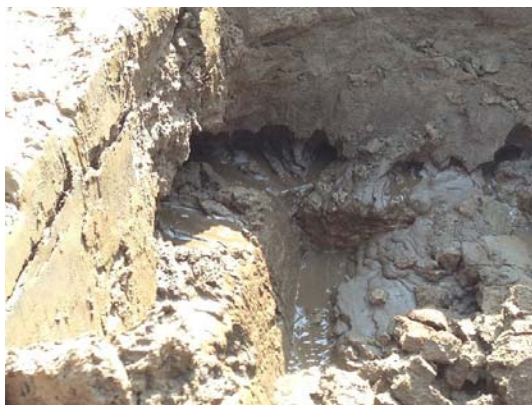
矢部川堤防決壊箇所付近（R7.3 付近） の開削堤防断面からの地下水浸出状況
