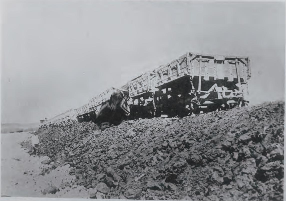
(13) 千代川改修工事機械掘鑿土捨作業
