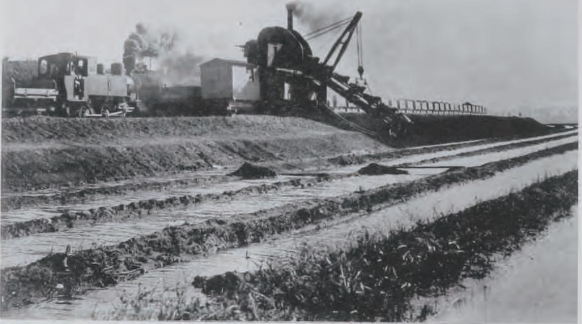
(12) 筑後川改修工事機械掘鑿
