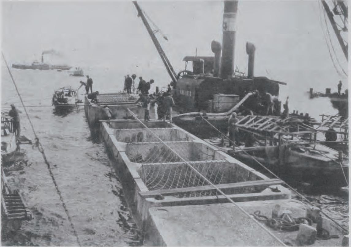
(20) 神戸港修築工事南防波堤築造
