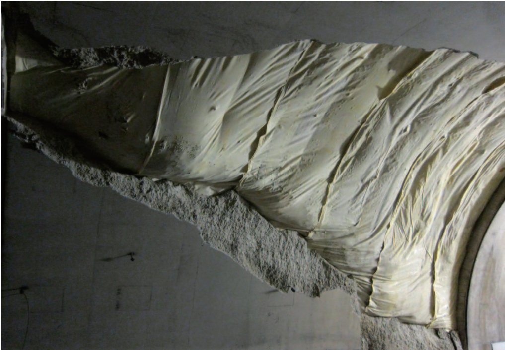
写真 3.2.2 俵山トンネルのスパン 167 付近の状況(正面)
