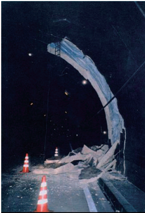
写真 2.2.1 盤滝トンネルにおける覆工の破壊(その1) 225) 図 2.2.2 盤滝トンネルにおける覆工の破壊(その1)
