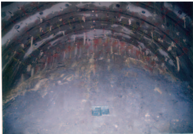
写真 3.3.3 南阿蘇トンネルにおける No.260+18 付近の補助工法施工後の状況
