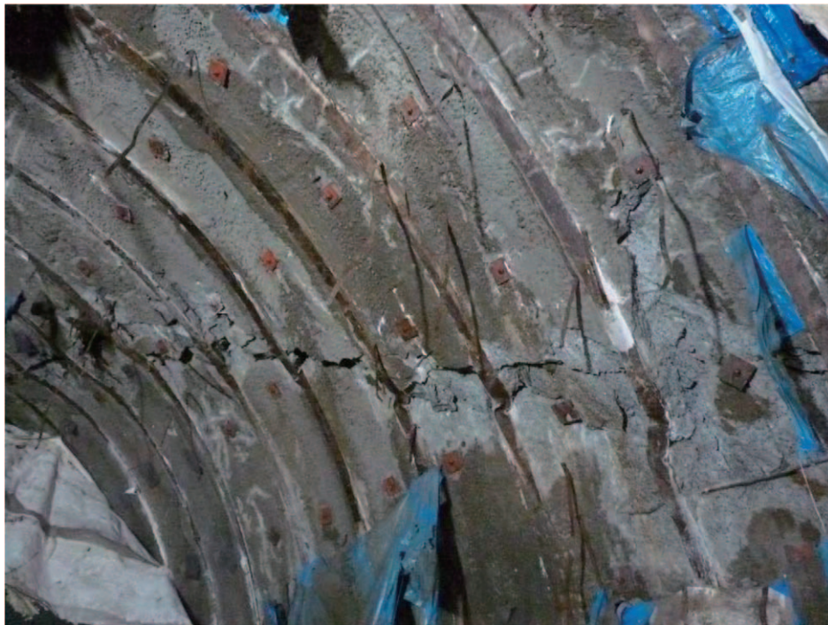
写真 3.2.4 俵山トンネルのスパン 167 付近の支保工の状況 (覆工撤去後)
