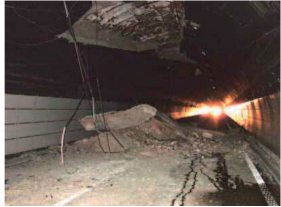
図 2.3.4 和南津トンネル長岡側坑口から 100m 付近の被害の状況
