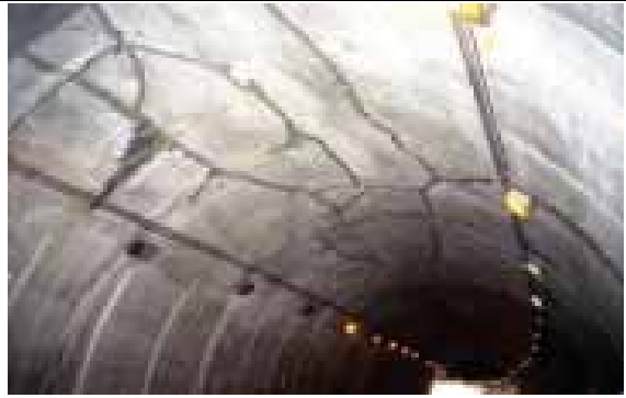
写真2：ひび割れ補修工実施後
