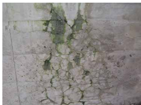
写真-3.18 アルカリ骨材反応
