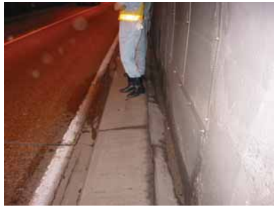
側溝の変形
