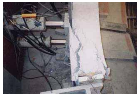
写真-3.5 せん断破壊の状況
