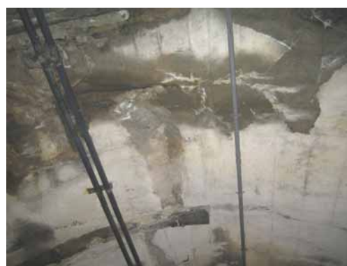
写真-3.8 膨張性土圧による圧ざ
