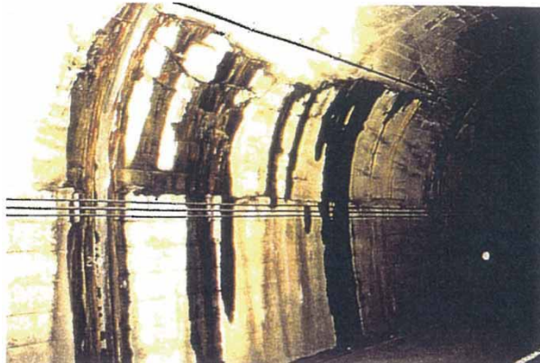
250m付近 山側アーチ部 ひびわれからの漏水
