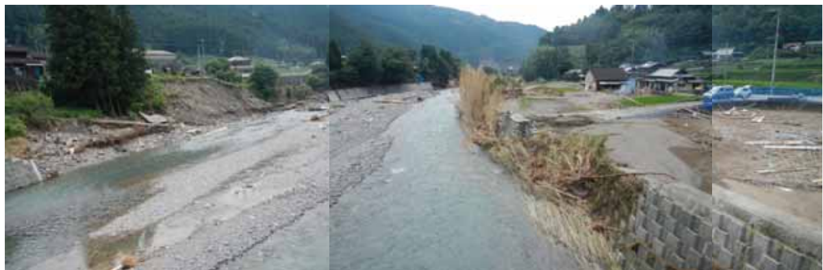
水位観測地点光延橋から下流を望む
